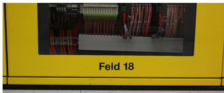
Abbildung 8: Bezeichnung Feldnummer Hauptverteilung (unten)
