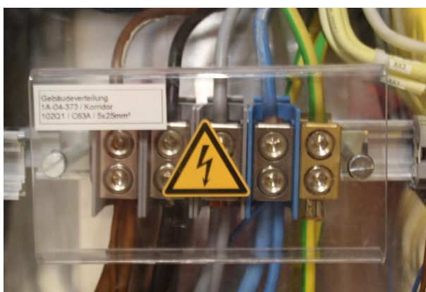
Abbildung 3: zusätzlicher Berührungsschutz der Einspeiseklemmen
