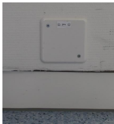
Abbildung 43: Anschluss ableitfähiger Boden
