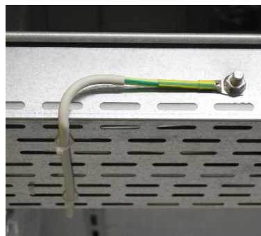
Abbildung 45: Anschluss Trasse
