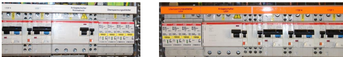
Abbildung 64: Bezeichnungstreifen in Schaltgerätekombination nach Netzart bezeichnet
