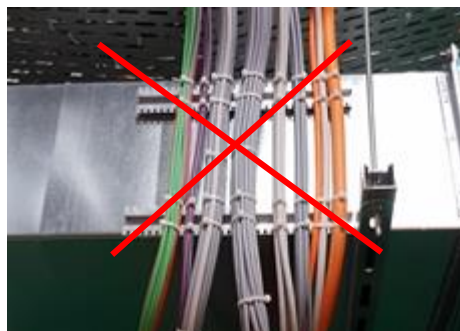
Abbildung 28: Profilschiene an Lüftungskanal geschraubt
