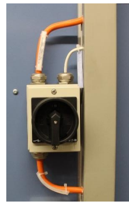
Abbildung 32: Revisionsschalter Lüftungsmotor
