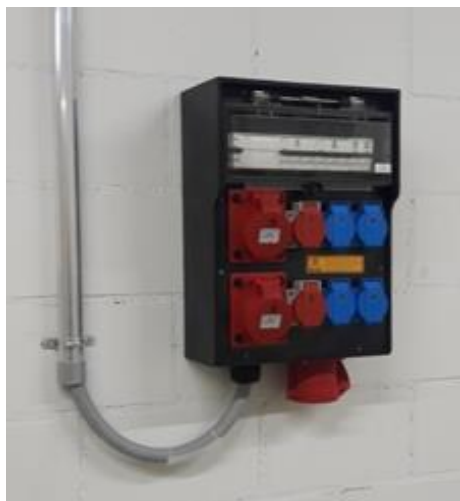
Abbildung 49: Steckdosenverteiler 32 A Gifas
