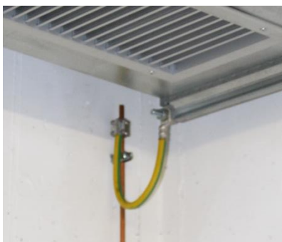
Abbildung 44: Anschluss Lüftungskanal
