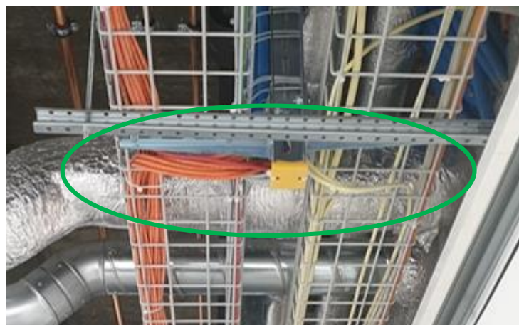
Abbildung 30: abgehende Kabel aus Elektrotrasse (Foto)
