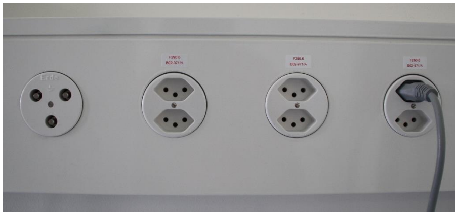
Abbildung 40: ZSPA-Anschlüsse in Medienkanal
