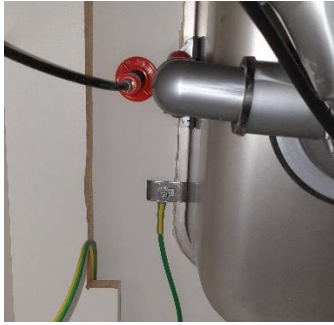
Abbildung 48: Anschluss Lavabo aus Chromstahl
