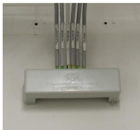
Abbildung 47: ZPA-Verteiler
