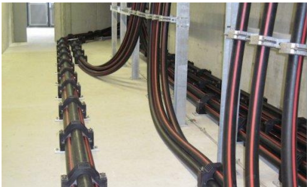
Abbildung 11: Kabelbefestigung MS-Kabel
