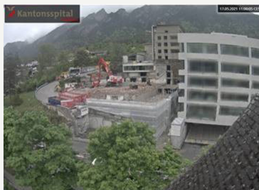
Webcam 2 Baustelle SUN
