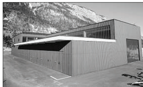
Neue Solaranlage: Das Unterwerk Vial in Domat/Ems nimmt die 40kW-Fotovoltaikanlage in Betrieb. (Foto zvg)
