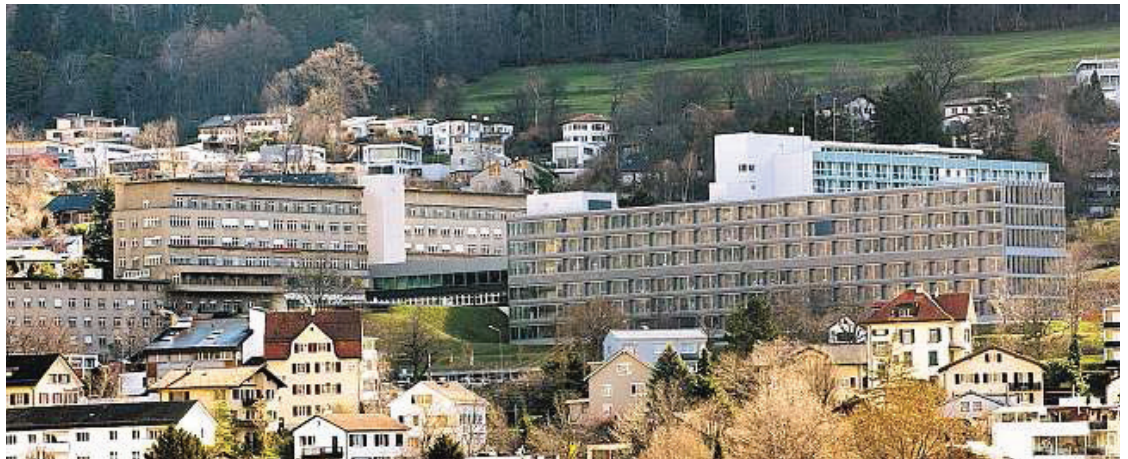
Hochsicherheitstrakt im Kellergeschoss: Das Kantonsspital Graubünden sichert und schützt Patientendaten mit grossem Aufwand.
