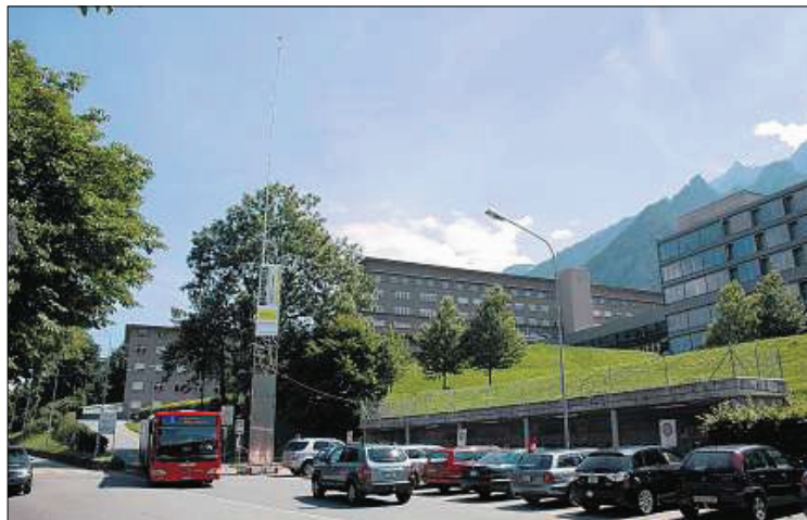
Die Profile für den Quartierplan sind montiert: Blick auf den künftigen Eingangsbereich des Kantonsspitals Graubünden, das von der Loestrasse her neu erschlossen wird. (Foto Norbert Waser)
